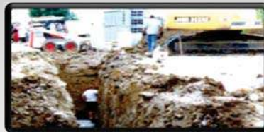
ขุดลึกเกิน 1.5 เมตร เป็นงานอับอากาศ
